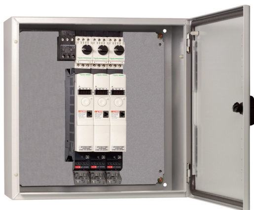
Пример прямого крепления автоматического выключателя GV2 и преобразователя частоты ATV 32 в шкафу: автоматические выключатели GV2 L + принадлежности GV2 454 и GV2 G05 + преобразователи частоты ATV 32HU15N4
